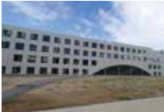
敷地内は現在も工事進行中
