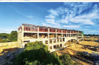
建設中の語学学修専用棟校舎
