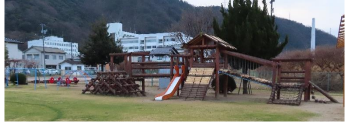
アスレチックの不具合な部分を取り換えて補修をしました。朽ちていたシーソーの赤い板を取り換えました。
